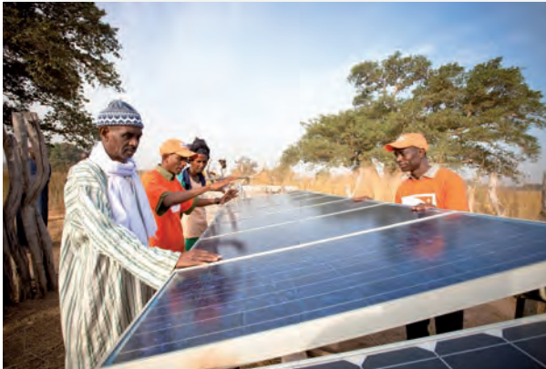
Gemeinsames Aufstellen von Solarpaneelen
